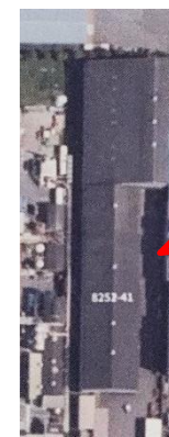
築30年 スレート屋根
